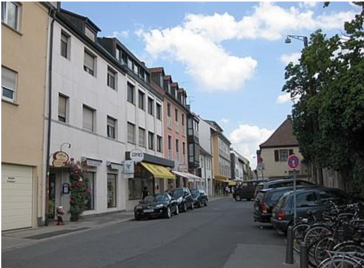
Südliche Stadtmauerstraße vor der Sanierung Juni 2011
