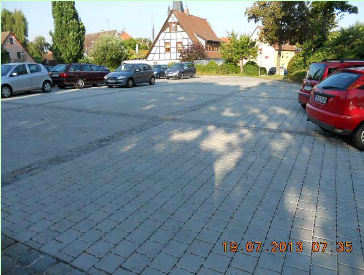
Brucker Festplatz: Belagserneuerung Rasenpflaster Bauzeit: 2012 Kosten: 55.000 Euro
