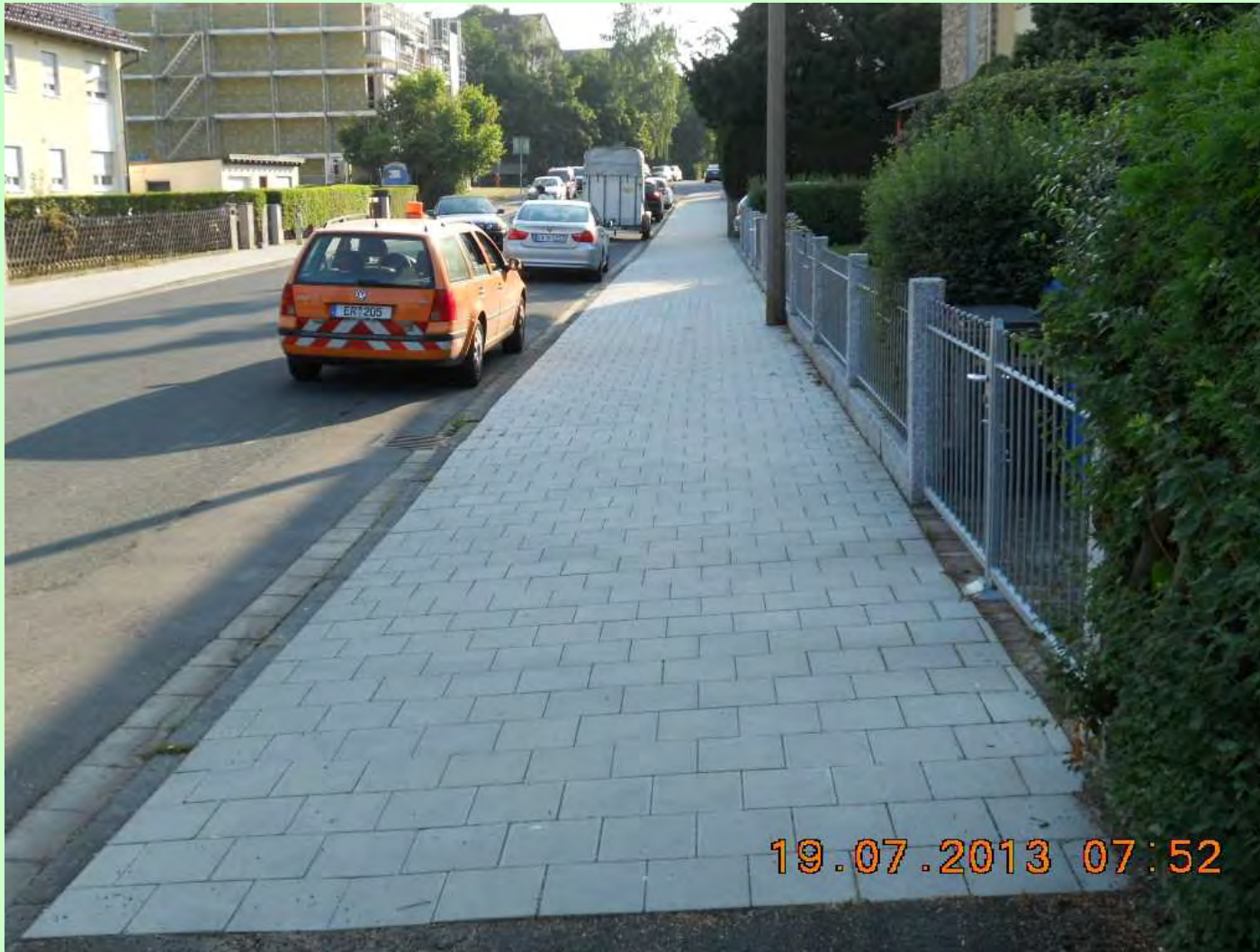
Buckenhofer Weg: Gehwegsanierung Bauzeit: 2011 Kosten: 20.000 Euro
