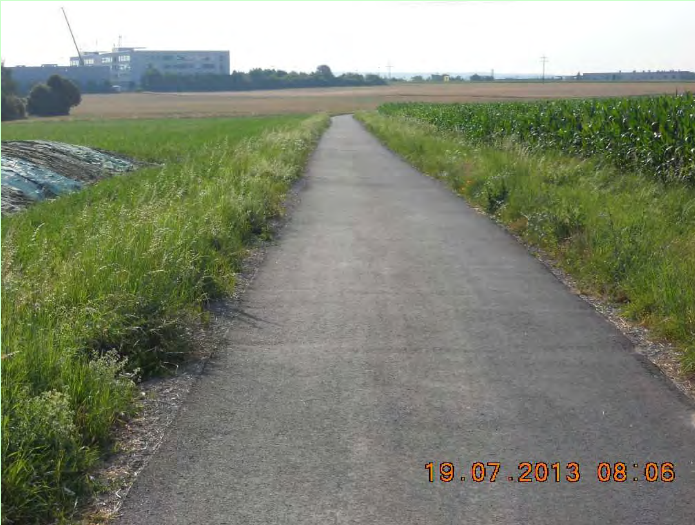
Verbindungsweg Steudach - Geisbühl: Asphalterneuerung Bauzeit: 2012 Kosten: 17.000 Euro
