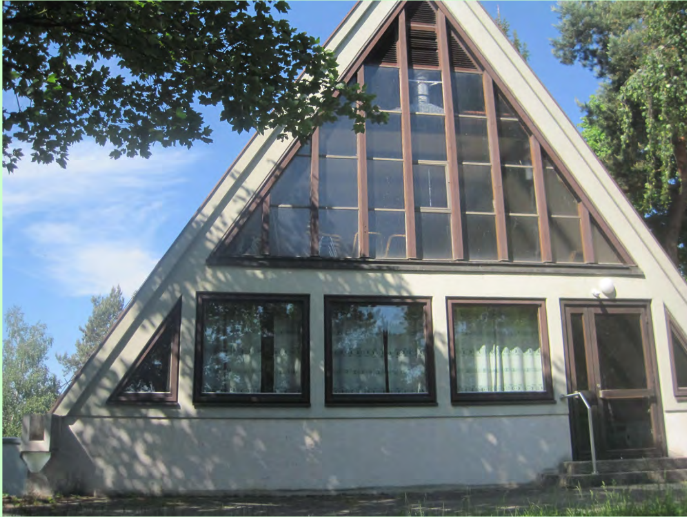
Kapelle Steudach: Erneuerung der Fenster Bauzeit: 6/2013 bis 8/2013 Kosten: 65.000 Euro
