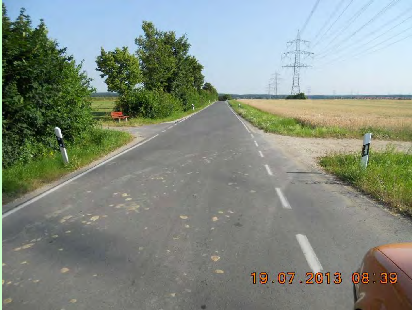
Kieselbergstraße: Asphaltdeckenbau Bauzeit: 2011 Kosten: 49.500 Euro
