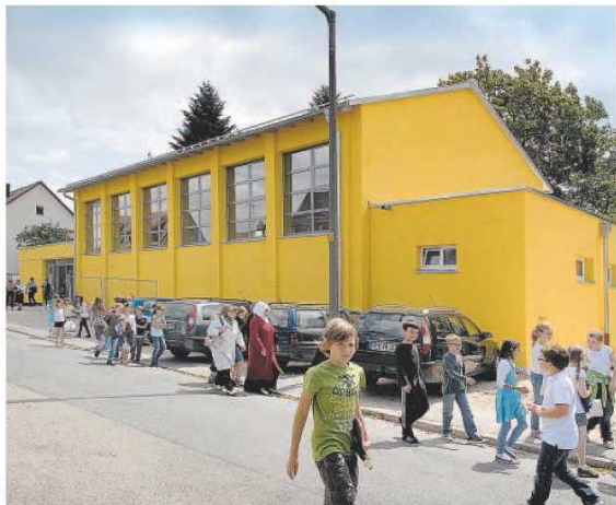
Die Turnhalle der Grundschule Büchenbach Dorf hat mit ihrer auch energetischen Sanierung zum guten Zustand der restlichen Schule aufgeschlossen.
