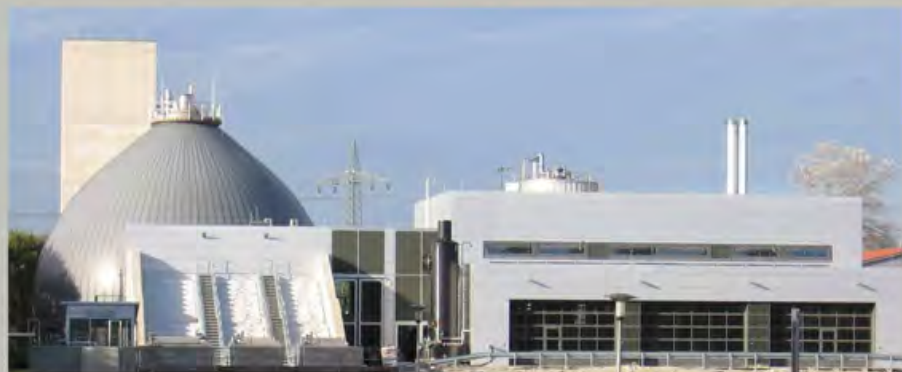
Das Klärwerk in der Ausbauphase.
