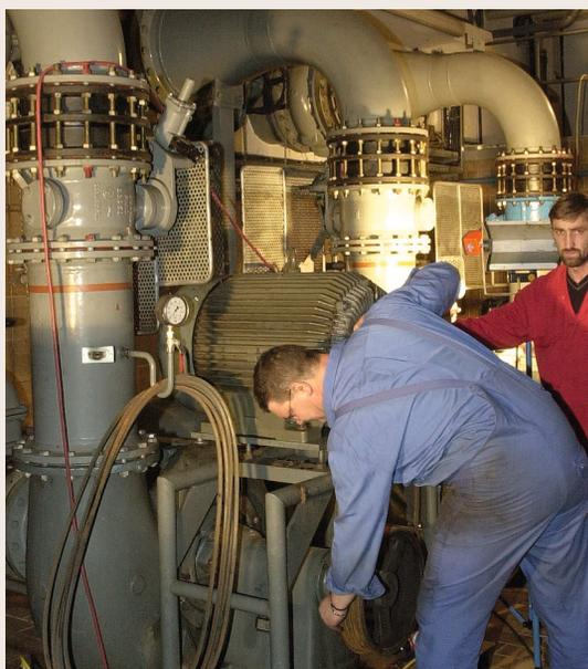
werks Bayern installieren Pumpen und verlegen Leitungen, um den Betrieb notdürftig aufrecht zu halten und einen Rückfluß des Erlanger Abwassers in die Regnitz zu verhindern. Nach viertägigem Einsatz kann durch die schnelle Reparatur der Hauptpumpen größerer Schaden verhindert werden.
