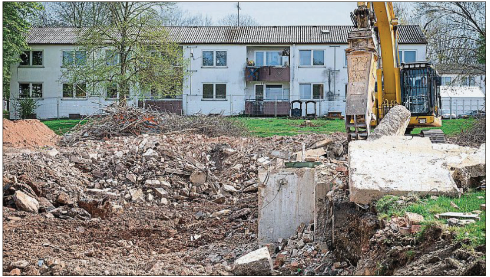
Die Abbruchkomponenten werden bestenfalls im Straßenbau wiederverwendet.
