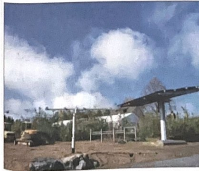
Hier entstehen die Solaranlagen für das Projekt in Arzberg. FOTO WRANESCHITZ
