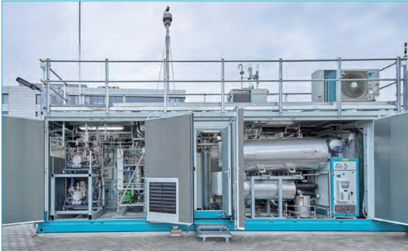
Abb. 4: Freisetzungsanlage von Wasserstoff der Fa. Hydrogenious LOHC Technologies an der Wasserstofftankstelle in Erlangen
